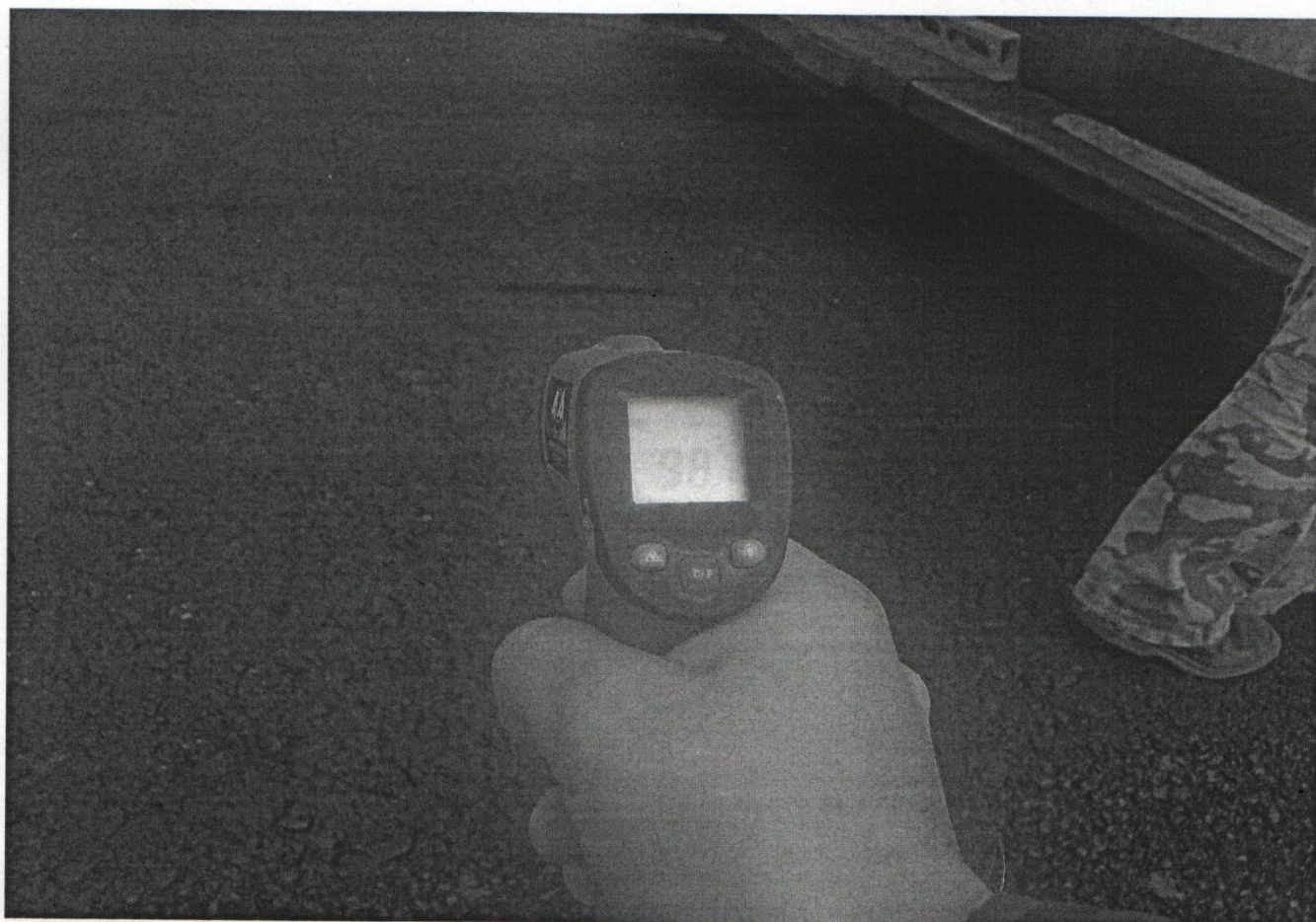
Измерение температуры сразу после плиты асфальтоукладчика (перед уплотнением t = 98^{\circ}\text{C} )
