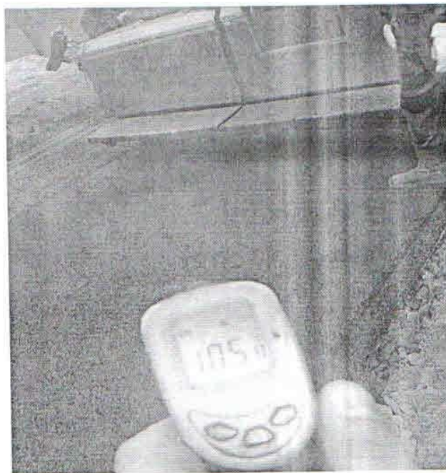
Измерение температуры сразу после плиты асфальтоукладчика (перед уплотнением)
